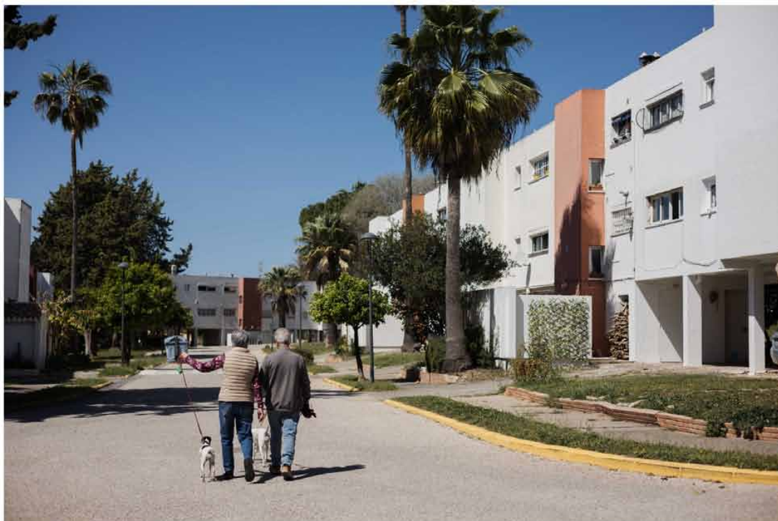
Urbaluz, el barrio fundado por americanos, sufre problemas de inundaciones.
