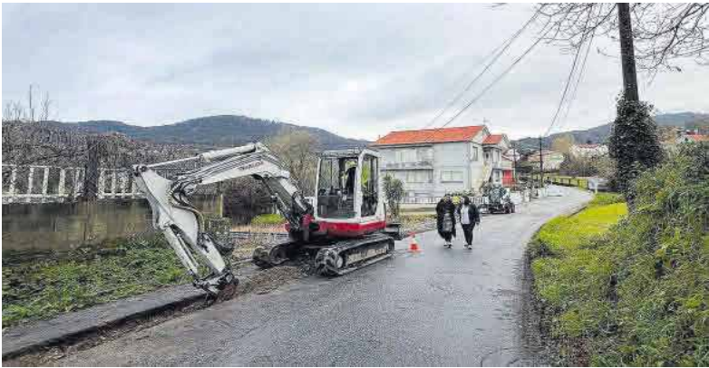
La alcaldesa y la concejala de Obras e Servizos supervisaron ayer los trabajos. | G.Núñez
