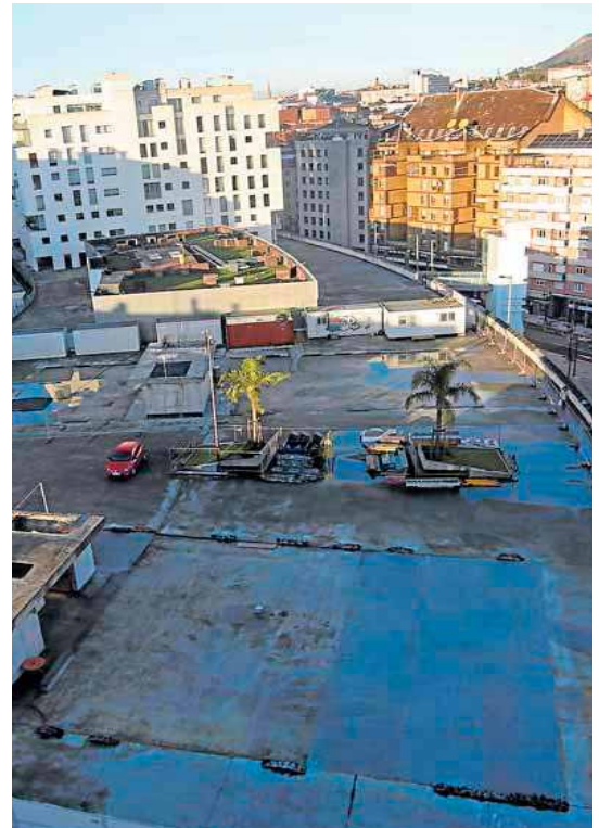
Zona en la que se construirán las dos torres sociosanitarias. M. ROJAS
